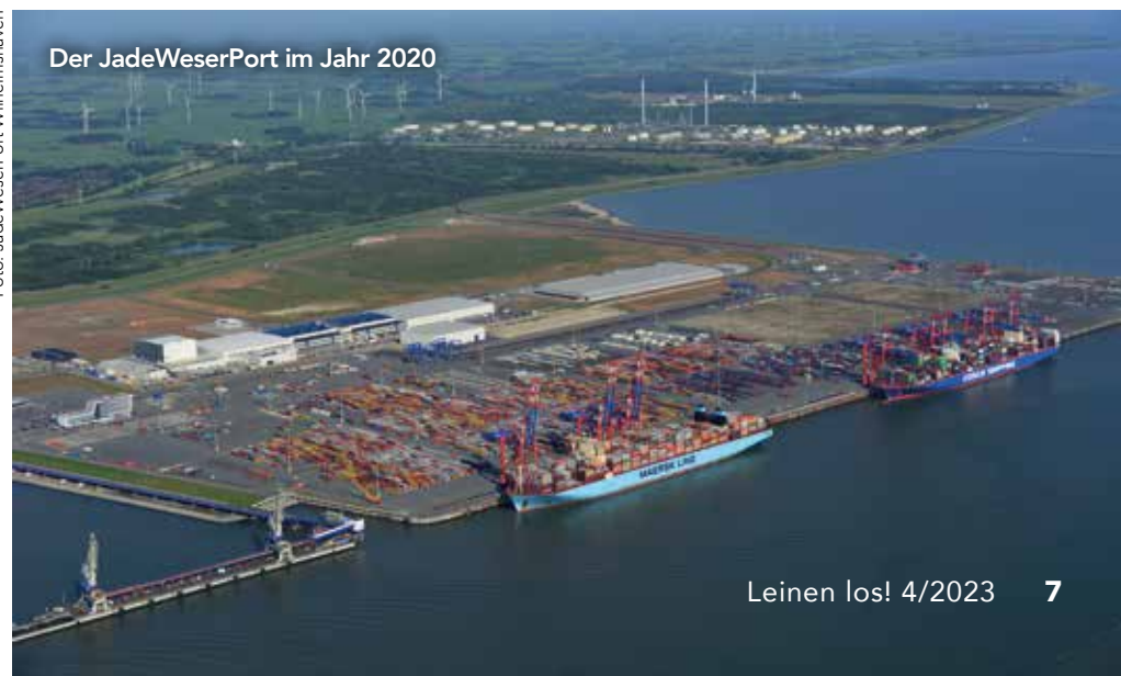
Foto: JadeWeserPort Wilhelmshaven
